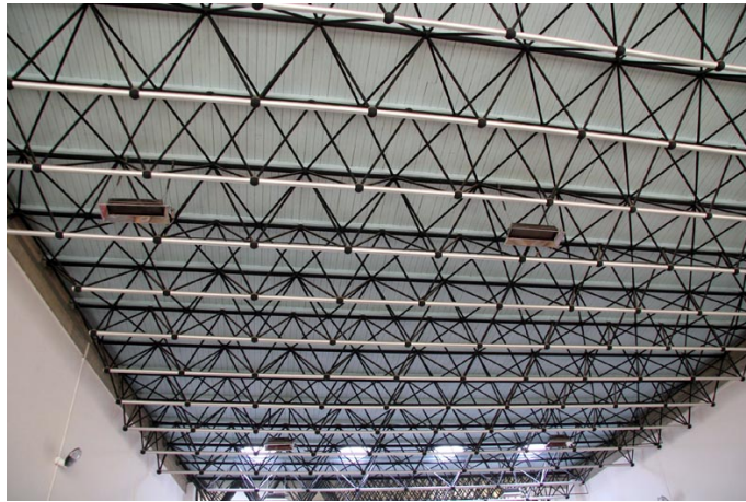
Fig. 26 - Plafond tri-dimensionnel de l'église de la Guérinière à Caen. Phot. Alain Nafilyan. © CRMH Basse-Normandie.
