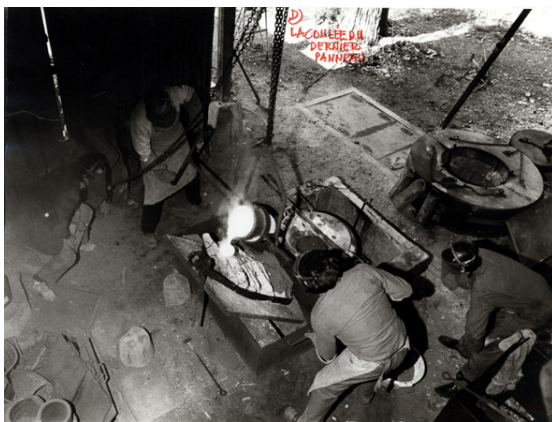
Fig. 6 - Fonte du bronze pour la réalisation des portes de Notre-Dame de Saint-Lô, coulée du dernier panneau. © Conseil général de la
